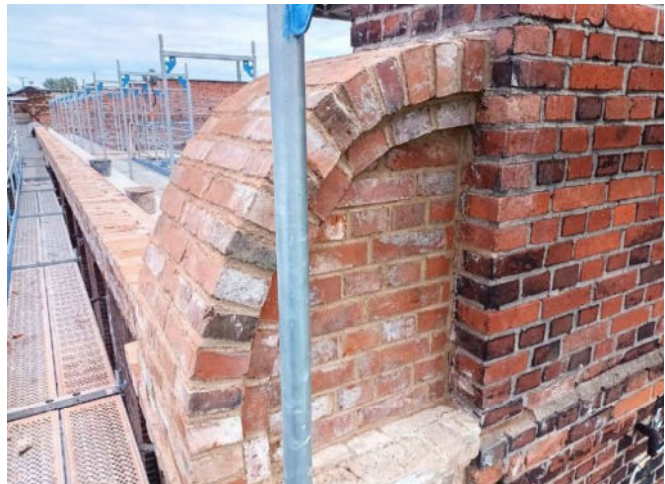
An der nördlichen Giebelwand wurde eine fehlende Zierecke neu aufgemauert. Foto: Florian Hahn
