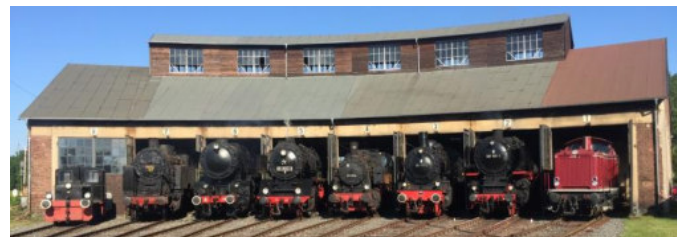
Nördlicher Lokschuppen Hanau
