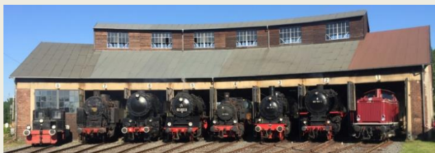
Nördlicher Lokschuppen Hanau
